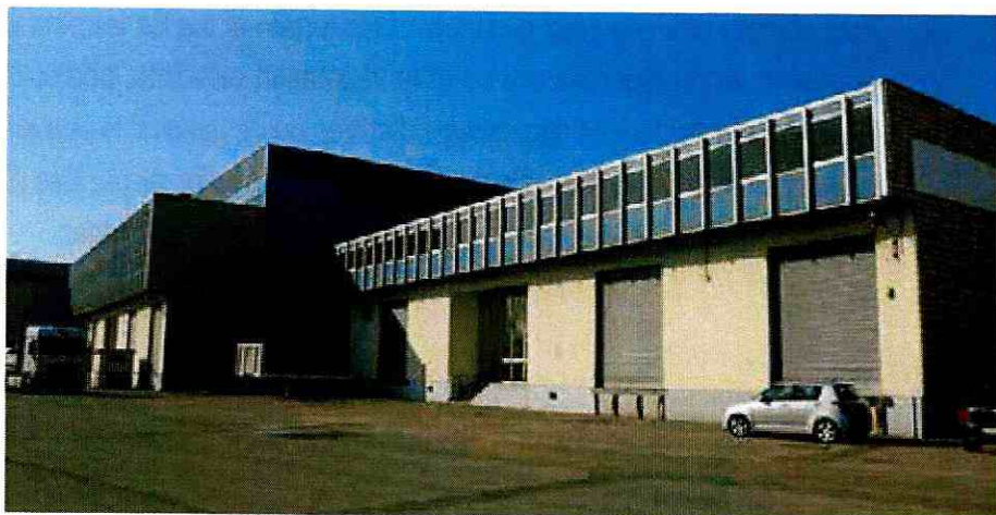
Photo 16 - Aire de chargement et de déchargement
