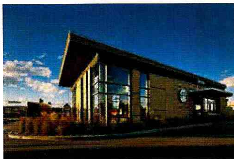
Photo 8 - Toit plat, en porte-à-faux Source: blog.ccm2.ca
